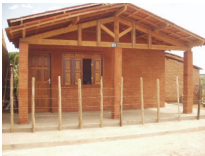
Ilustração 9 – Casa de tijolo de solo-cimento em fase final, feita pelos próprios moradores Crédito: Clovis, 2004
