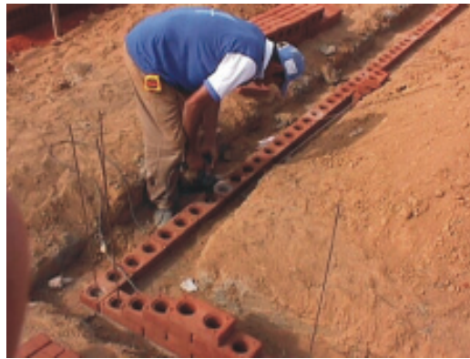
Ilustração 3 – Construção do protótipo de casa em tijolo de solo-cimento Crédito: Moscatelli/ 2003
